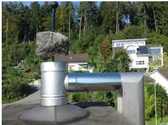
Bürste wird komplett nach oben durchgestossen
